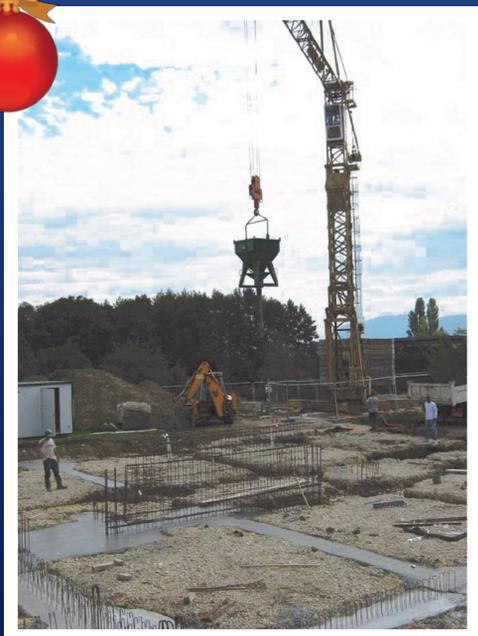
Le béton est amené au chantier dans un camion toupie. Il est toujours versé dans les trous que le tracto-pelle a creusés. Ce n'est pas fini ! Ils vont bientôt faire les murs, on voit les fers qui montent, ce sera le niveau du plancher de l'école.
