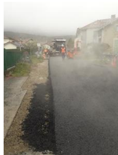
Travaux Rue du Mail
